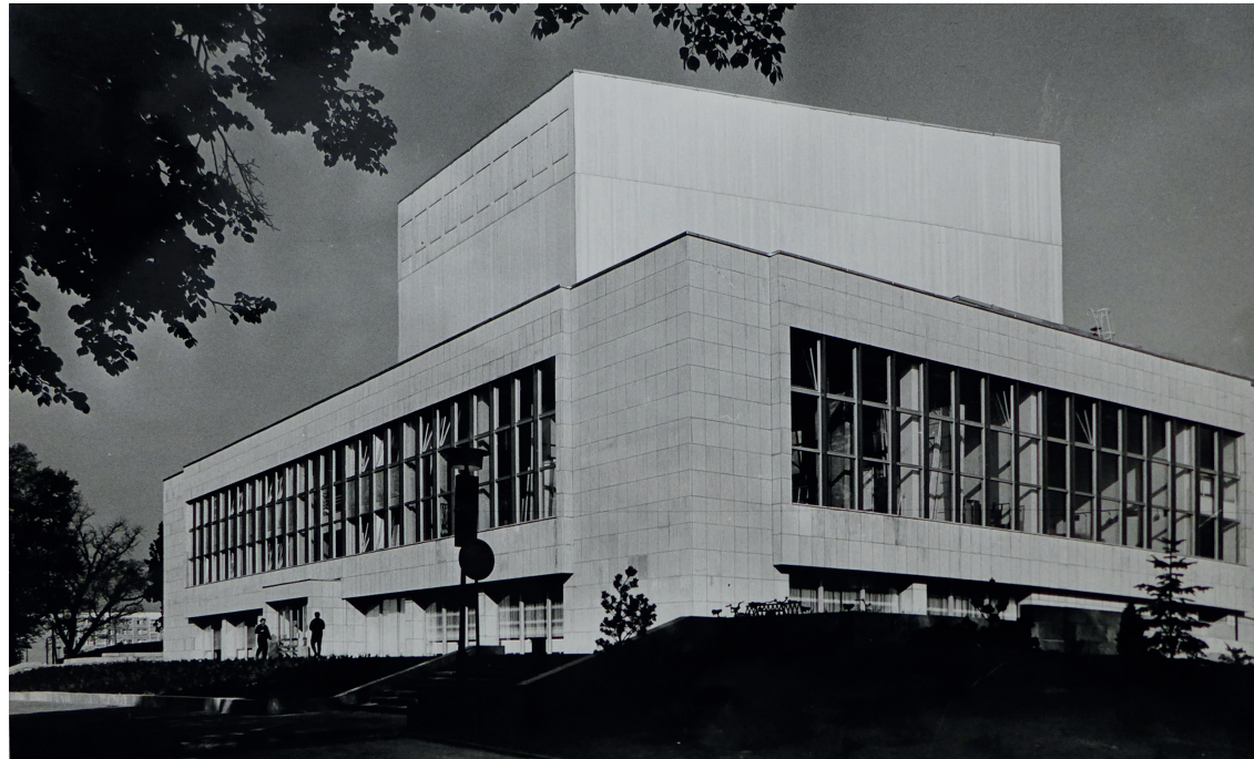
Kulturhaus Schwedt, Ansicht von Ost, © Rudolf Hartmetz | oben: Kulturhaus Schwedt, Baustellenfoto 1976-1978 © Archiv Uckermärkische Bühnen Schwedt
